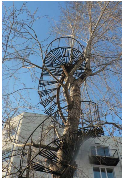
Рис. 6. Общий вид изготовленной лестницы
